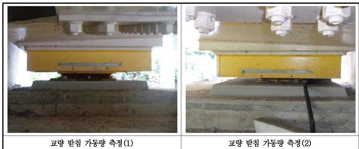
【사진 17.3.15】 교량받침 이동량 측정
