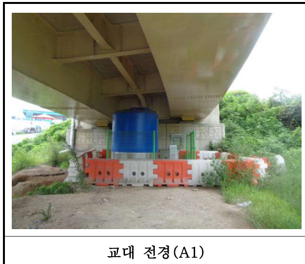
【사진 17.3.8】 교대 전경
