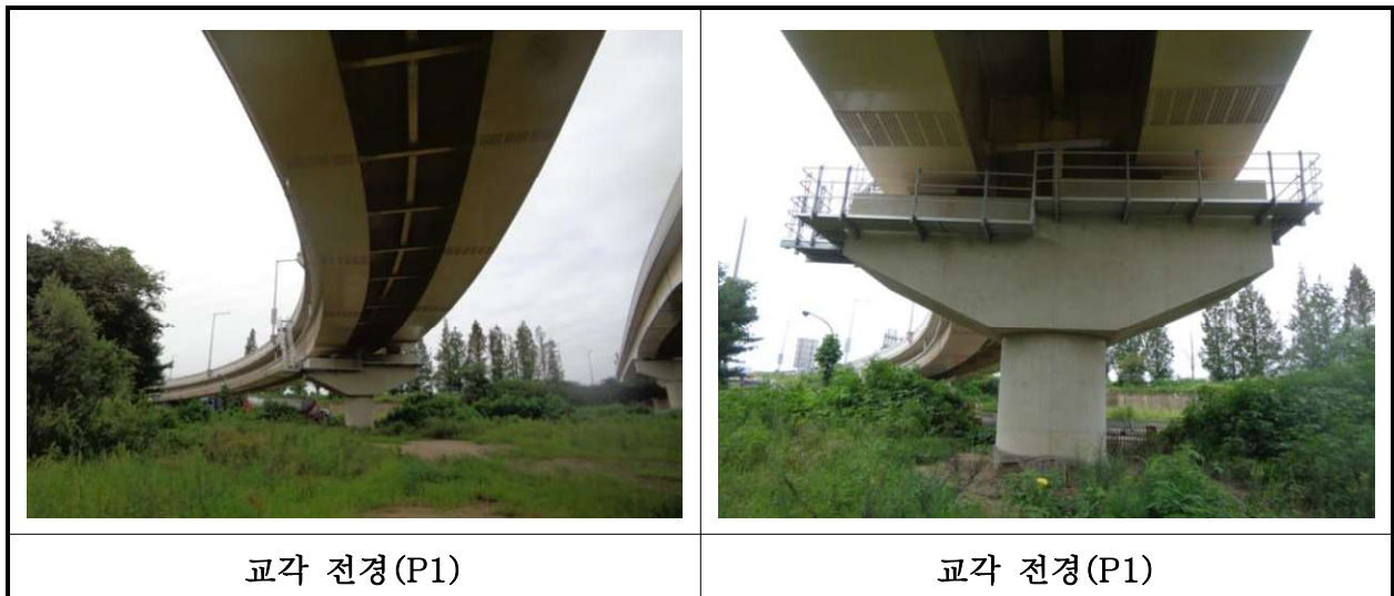
【사진 17.3.10】 교각 전경
