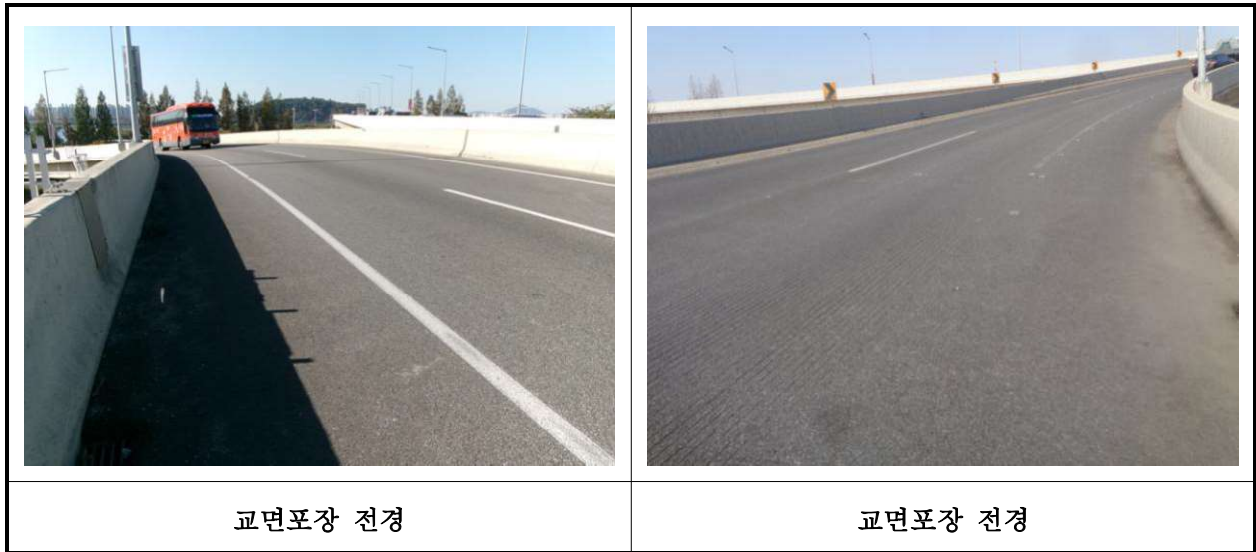
【사진 17.3.19】 교면포장 전경
