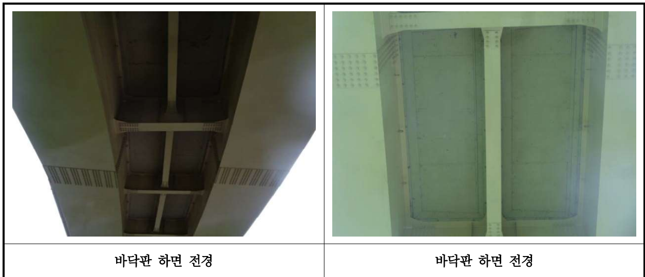
【사진 17.3.2】 바닥판하면 전경
