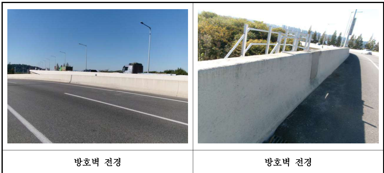
【사진 17.3.23】 방호벽 및 중앙분리대 전경
