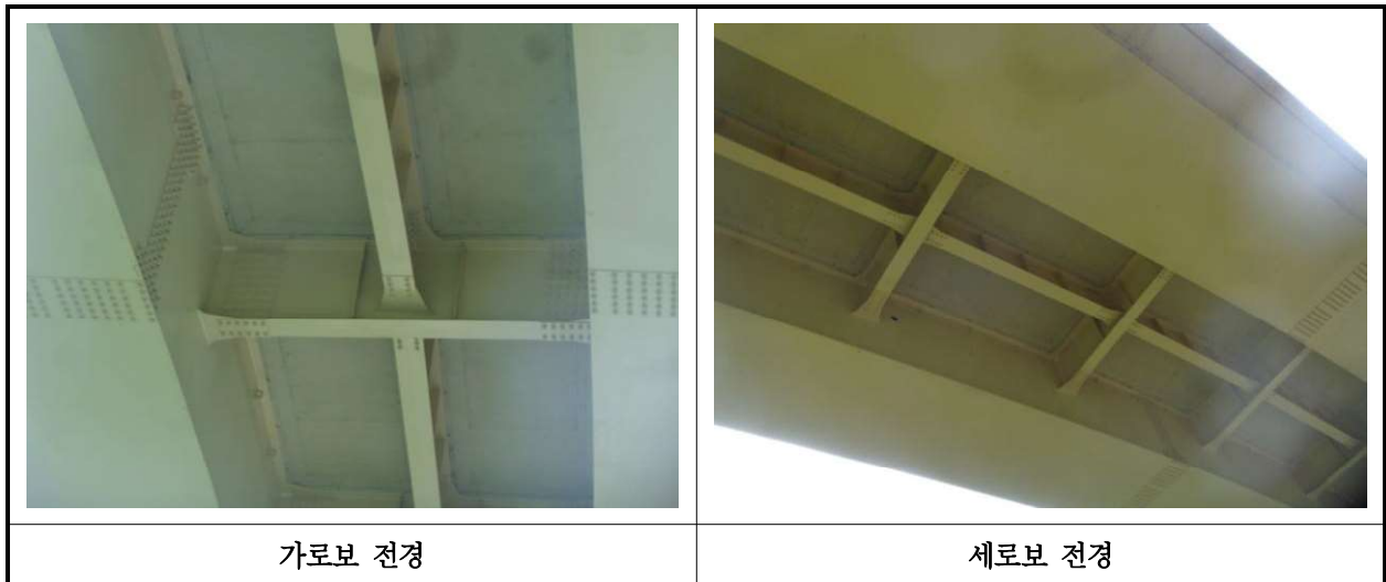
【사진 17.3.6】 가로보 및 세로보 전경
