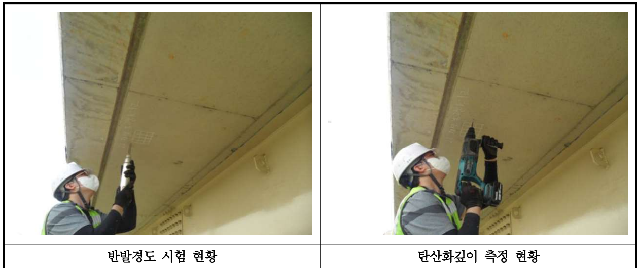
【사진 17.4.1】 콘크리트 내구성조사 현황
