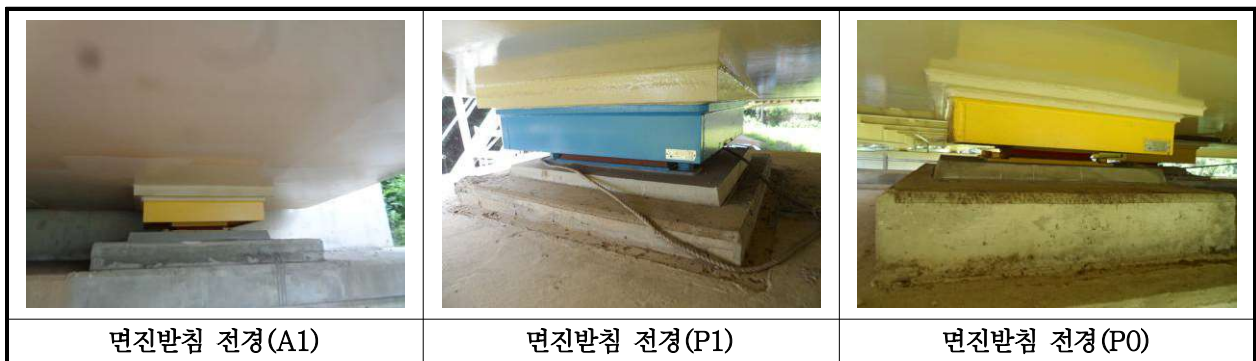
【사진 17.3.12】 교량받침 전경
