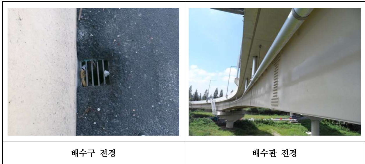
【사진 17.3.21】 배수시설 전경
