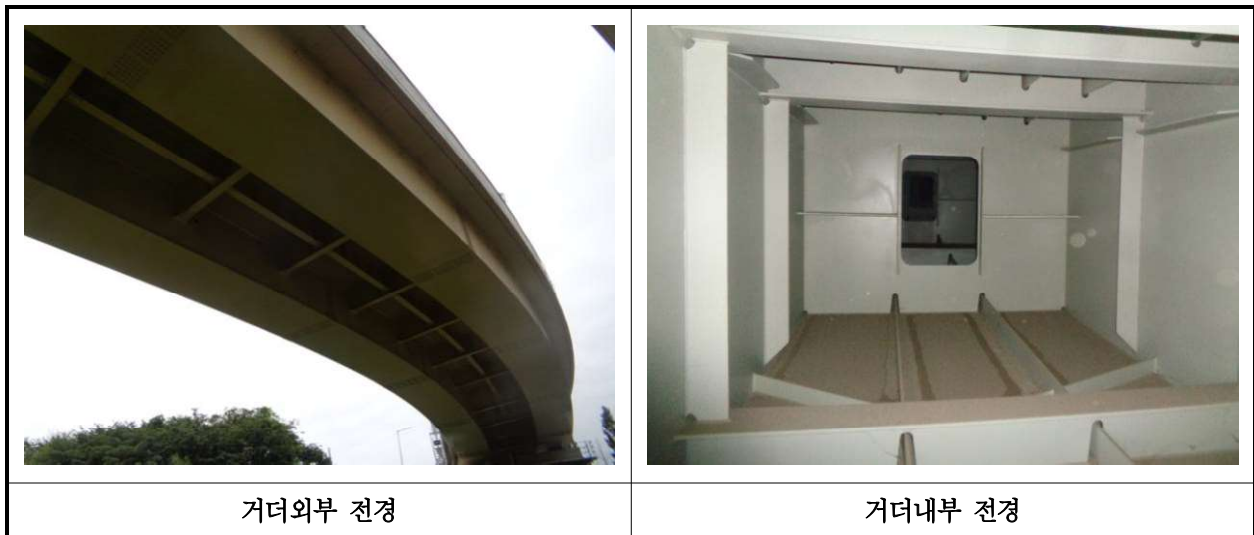
【사진 17.3.4】 거더 전경
